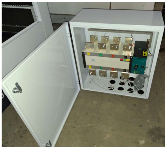
Fig 5. Muestra el ATS.
